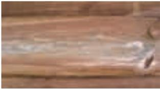
**SALZAUSBLÜHUNGEN:** Vor allem im ersten Jahr nach der Fertigstellung kann es vereinzelt zu Harzaustritten in dieser Form kommen. Durch die Kesseldruckimprägnierung wird das Harz grün-weiß eingefärbt. Dadurch entstehen kleine Flecken auf der Oberfläche. Die Sonne härtet diese Flecken und diese können dann abgebürstet oder abgewischt werden. Mit der Zeit verwittern sie auch von alleine und stellen keinen Grund zur Beanstandung dar.
