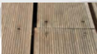
**BREITENVERSATZ:** Der Stoß zweier Terrassendielen in einer Fläche birgt immer die Möglichkeit, dass es zu einem Breitenversatz durch unterschiedlich starke Aufnahme und Abgabe von Feuchtigkeit kommen kann.
